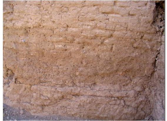
Ces détériorations peuvent être dues au mauvais fonctionnement des circuits d'évacuation de l'eau suite à l'abandon de la citadelle ou aux travaux de rénovation, comme c'est probablement le cas de ce mur au sud des baraquements et proche du puits. Le couloir qui assurait sa ventilation a en effet été muré lors des rénovations.
