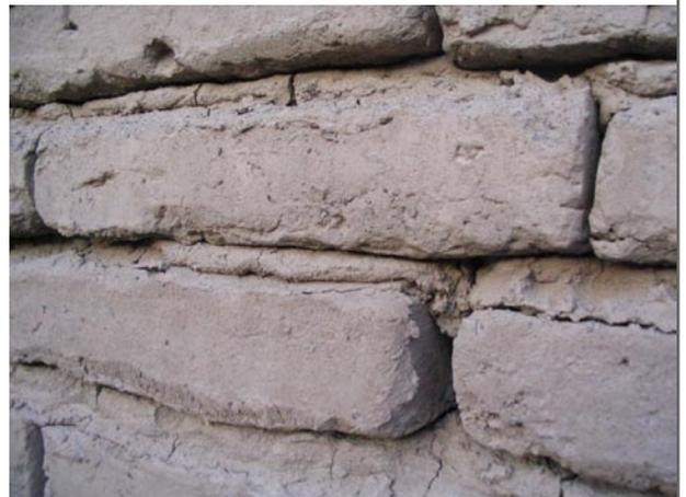
La réalisation des voûtes et coupoles est en générale plus soignée, étant confiée aux maître-maçon, mais on doit quand même constater une diminution de la qualité de celles-ci. De même, on observe globalement un manque de soin dans le traitement des joints.
