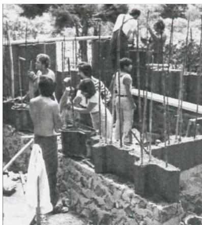
Elle est constituée d'éléments de 80 cm de large en pisé avec des renforts verticaux en bambou.
