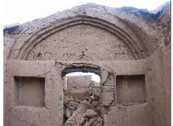
Un bel exemple de cette technique, avec un appareillage beaucoup plus riche, se trouve dans le bazar de Kerman. En effet, on ne trouve plus aucune de ces structures debout à Bam, leur résistance au séisme semblant très faible.
