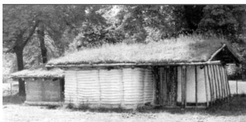
Des boudins de tissus sont remplis puis empilés. Des renforcements verticaux en bambou sont plantés dans les murs et fixés à un chaînage en bois qui supporte la toiture.
