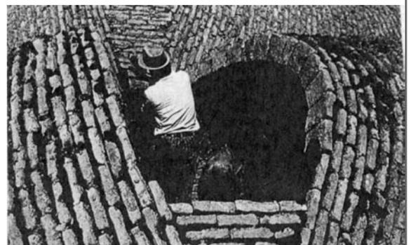
Le point le plus délicat avec ces voûtes que l'on peut apparenter à des coupôles est que, même si l'utilisation de gabarits dans les diagonales est possible, la gaucherie des assises fait que la qualité géométrique dépend au final uniquement de la maîtrise du maçons et tant de l'acuité son oeil que de l'habileté de sa main.
