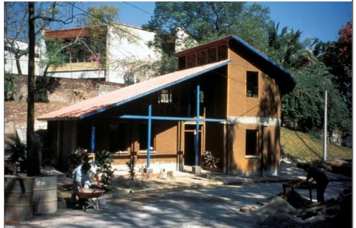
Le bâtiment a subi le tremblement de terre de 2000 ( $M_s=7$ ) sans aucun dommages à part une fissure entre la dalle en béton et le mur en adobe.
