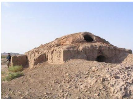
Ce four à briques en adobe a la particularité d'avoir une ouverture dans sa voûte. D'un côté, la forme s'apparente à une voûte en navette, comme on en rencontre parfois dans l'Arg, mais appuyée sur un mur pignon avec des assises en arc de cercle typique. De l'autre côté, on voit des trompes d'angles sur lesquelles s'appuient différentes assises d'orientations variables pour encadrer l'ouverture.
