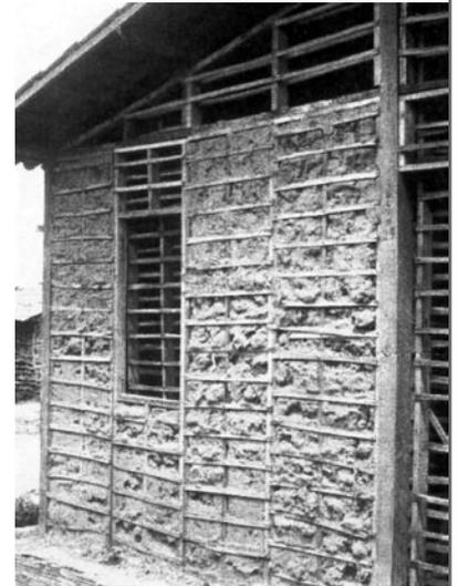
L'équipe de M. Kühn, Poblete et Trebilcock, à Santiago de Chile au Chili a conçu un système modulaire mixte. Le toit est supporté par des poteaux en pisé renforcés par des armatures verticales. Leur forme de croix leur confère un caractère autostable. Les murs et cloisons sont réalisés en torchis.
