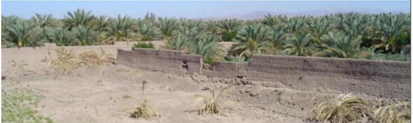
Le *chiney* est le nom iranien pour la bauge ou terre empilée. La terre à l'état plastique est utilisée sous forme de boules qui sont empilées et façonnées pour former une assise de mur d'une hauteur de 60 cm environ. Chaque couche de mur est laissée à sécher avant d'y empiler la couche suivante. Les murs en chiney ont un fruit très important. Beaucoup sont faits de 7 couches (connus sous le nom de *haft chiney*) et atteignent quatre mètres de haut.
