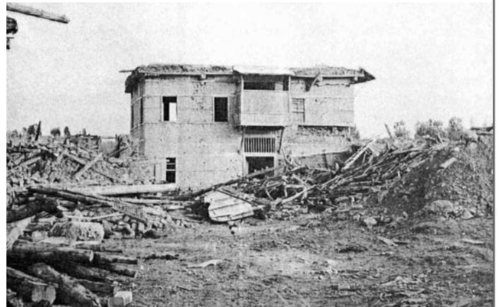
Sur celle-ci, après le tremblement de terre de Gediz en 1970, on voit que malgré des mouvements de sols importants comme le montre la rupture en rouge, les fissures dans les murs ont été arrêtées par les renforcements en bois.
