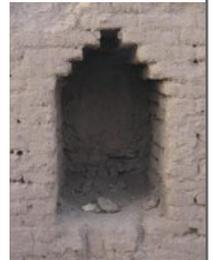
On trouve cependant quelques arcs à encorbellement. Celui-ci se trouve dans un caravansérail à l'extérieur de Bam. On trouve aussi des arcs en mitre pour des petites ouvertures, notamment dans les remparts de la citadelle.
