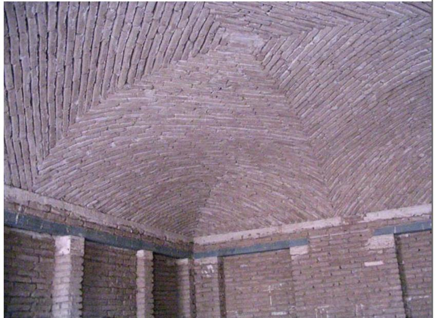
Cependant, dans de nombreux autres cas, l'appareillage traditionnel est remplacé par un appareillage qui se rapproche de celui d'une voûte en auge, avec des assises verticales montées au plâtre après des coins montés en assises horizontales.
