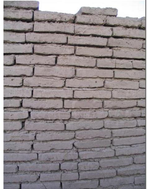
Il est fréquent de trouver des joints verticaux qui ne sont pas remplis. En outre, l'utilisation de mortiers trop liquide est indiquée par la forme caractéristique que montrent les joints.
