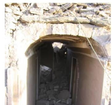
**Caténaire** : Ce tracé de voûte sur la forme de chaînette inversée (à moins que ce ne soient des paraboles) a été utilisé à Bam, comme le montrent les quelques exemples ci-dessous, notamment dans les remparts (photo de droite). Cette forme semble relativement rare, et l'on manque d'éléments pour établir les raisons de son utilisation limitée.
