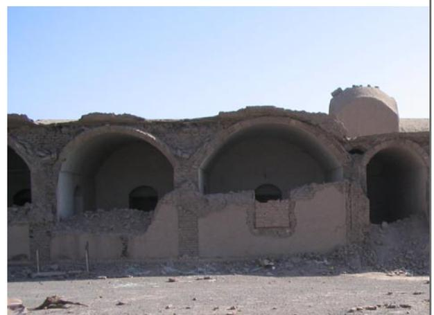
**Utilisation de structures en limite de stabilité:** comme l'a montré la mission de Serge Maini, de nombreux arcs, voûtes et coupoles sont en limite de stabilité à l'état statique. La maîtrise des techniques de franchissement des constructeurs Bami leur a sans doute permis de réaliser ces structures en connaissance de cause, mais elles ne sont en aucun cas adaptées aux contextes sismiques.
